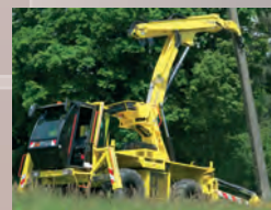
Chargement en direct des poteaux
